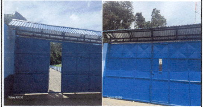
Foto 2: Se finaliza mantenimiento y techado del portón, partes adentro y afuera
