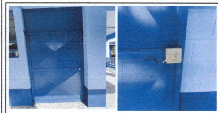
Foto 5: Pintura y cambio de chapas de puertas
