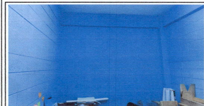
Foto 3: Finaliza pintura del interior de dirección y aulas
