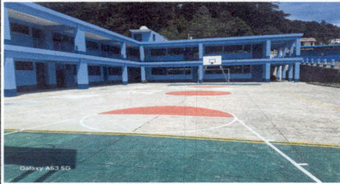
Foto 1: Se finaliza pintura del centro educativo
